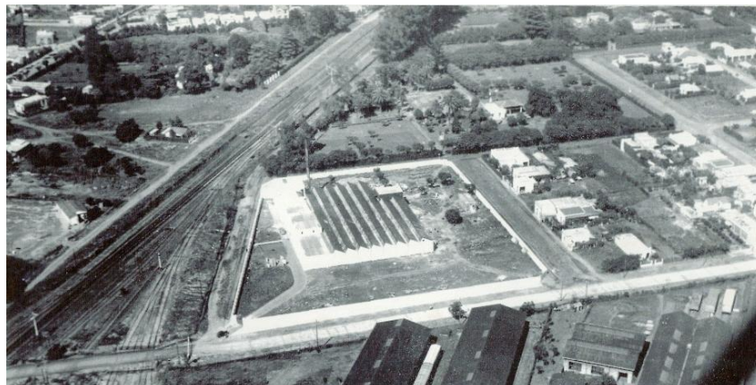
Vista aérea de la zona de La Cantábrica
