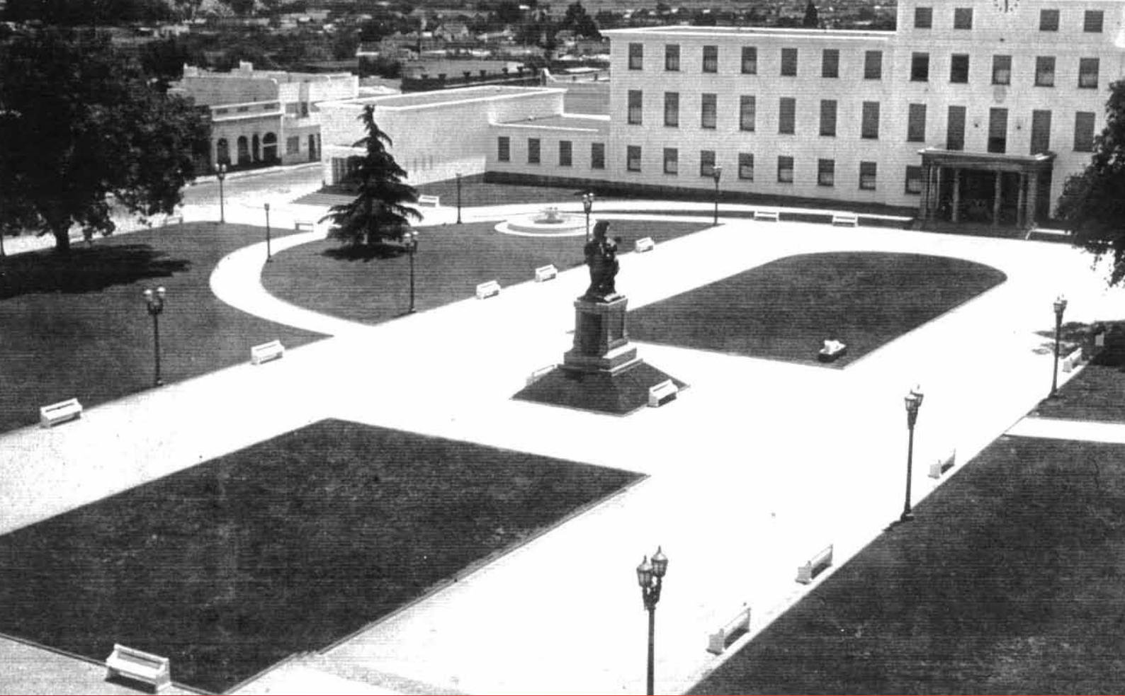
Palacio Municipal de Morón- Década de 1940- Vista desde la Plaza Alsina (hoy Plaza San Martín) donde aún se encontraba el Monumento a la Independencia que fue sustituido por el del Libertador en 1950.
