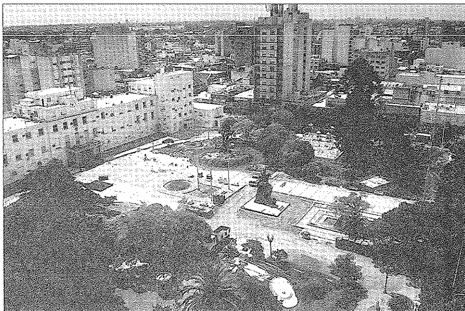
Vista aérea de la Plaza Libertador de Gral. San Martín, durante las obras de remodelación, 2006.
