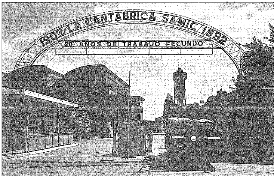
Entrada al Parque Industrial La Cantábrica.
