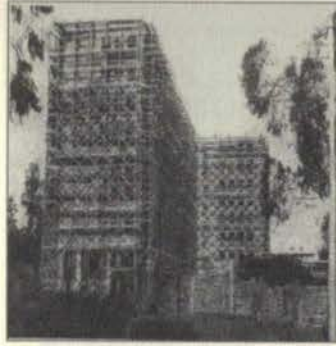
Edificio en construcción del Policlínico de Cirugía de Tórax, 1952.
