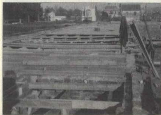
Obras de construcción del Colegio Ward.
